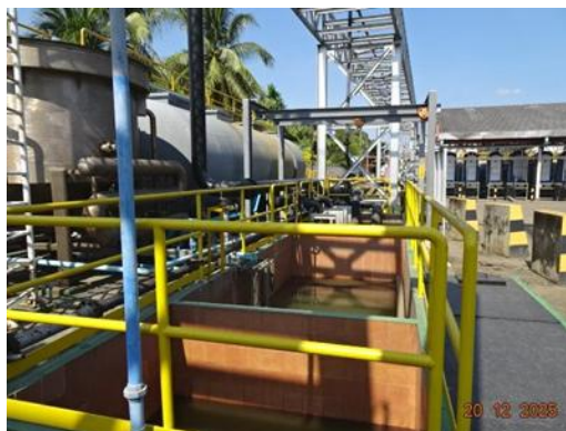
ภาพที่ 7 บ่อดักคราบน้ำมัน (Oil interceptor)
