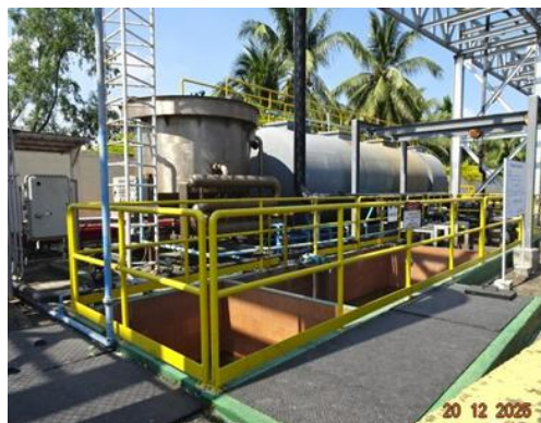
ภาพที่ 7 บ่อดักคราบน้ำมัน (Oil interceptor)
